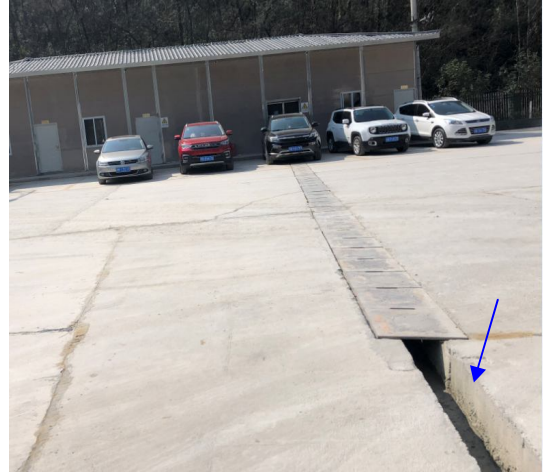
图 5-9 办公楼西侧上坡路处、搅拌站西侧已设置的导流沟
