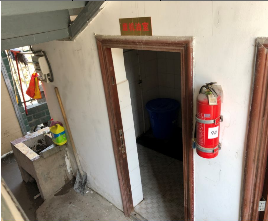
图 1-4 已设置的危废暂存间
