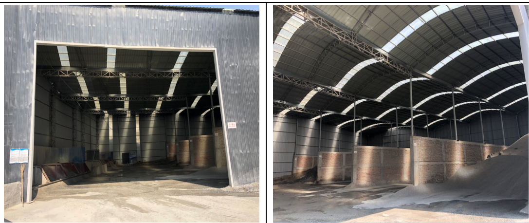
图 5-3 原料堆放实施的三挡一围处理措施
