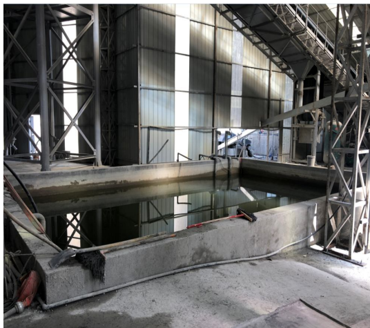
图 5-15 搅拌楼下已设置的储水池
