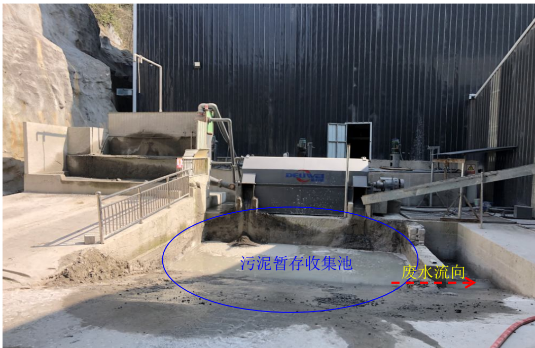
图 5-19 已设置的污泥暂存收集池
