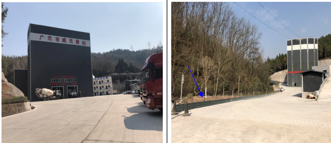
图 5-2 厂区道路已硬化现状、厂界设置的绿化带现状
