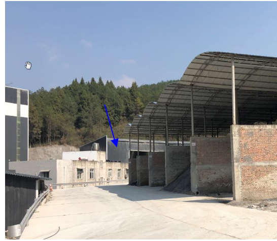
图 5-17 原料堆场封闭作业现状
