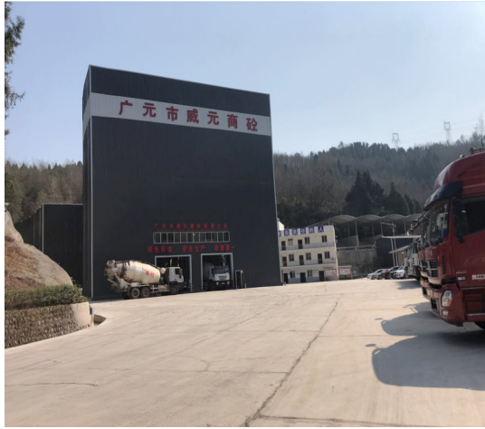
图 5-16 搅拌楼封闭作业现状
