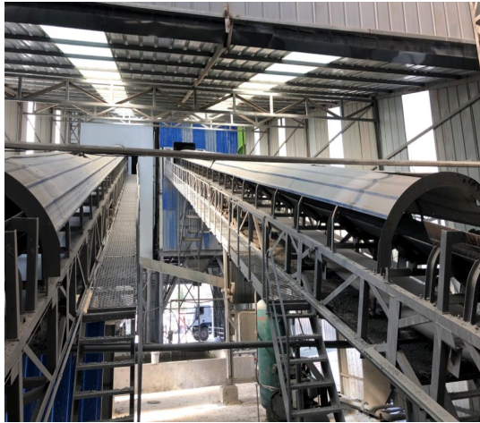
图 5-5 输送带已采取封闭治理措施
