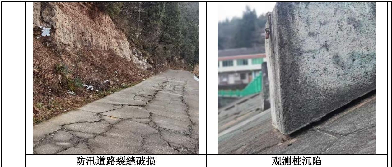
图 3-5 水库现状照片
