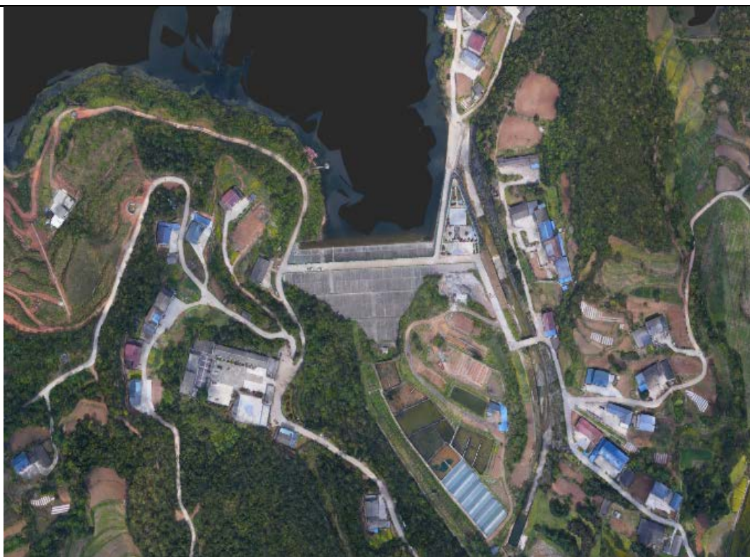
图 3-3 工水务农水库大坝全貌俯视图
