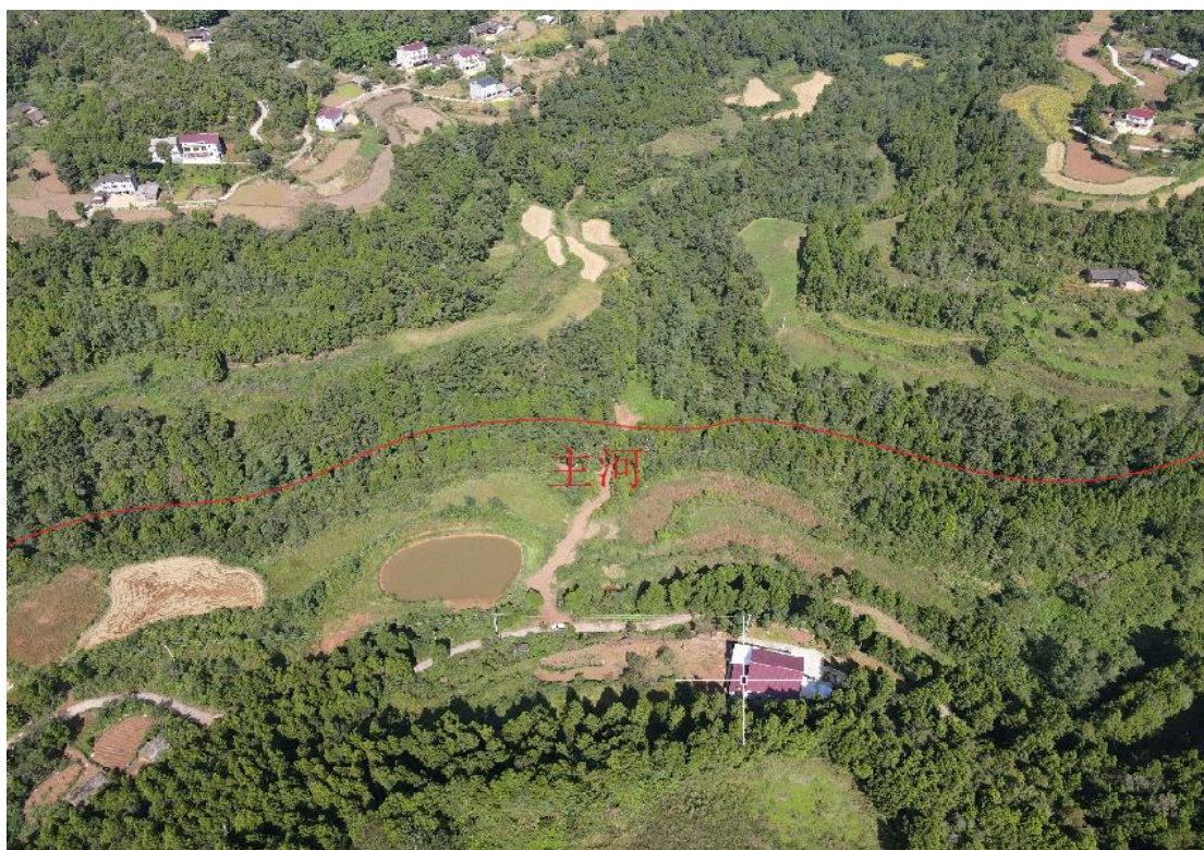
图 3.2-5 王滩河水库起点至马家渡口段航拍图
