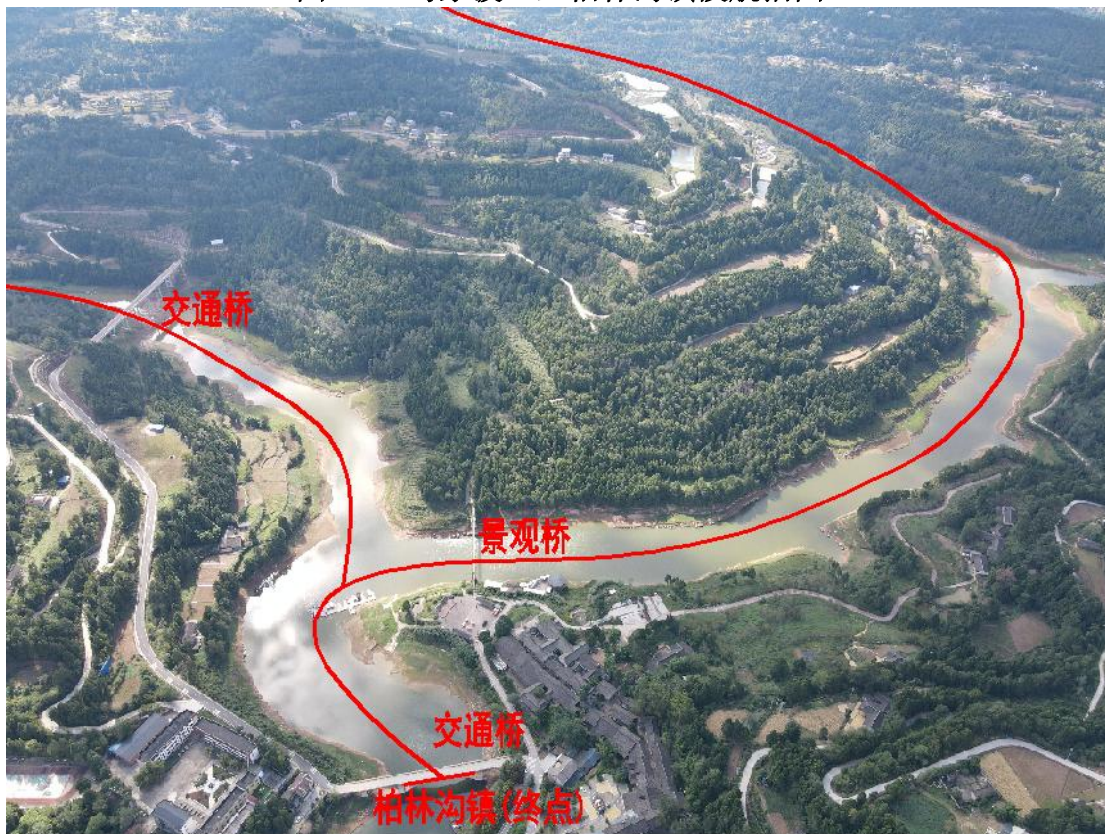
图 3.8 马家渡口至柏林沟镇段航拍图
