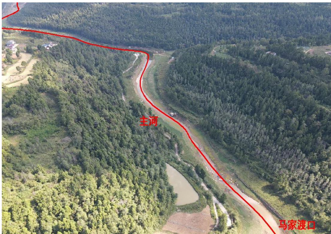
图 3.9 马家渡口至柏林沟镇段航拍图
