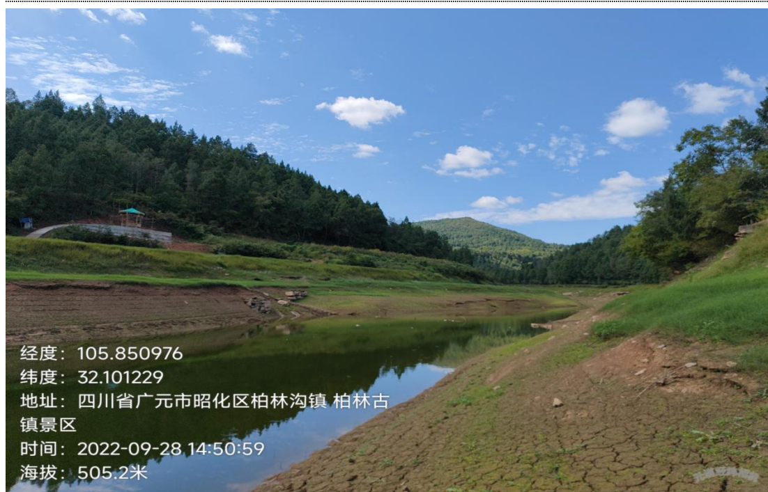
图 5.1-4 马家沟渡口至柏林沟镇段河段现场拍摄
