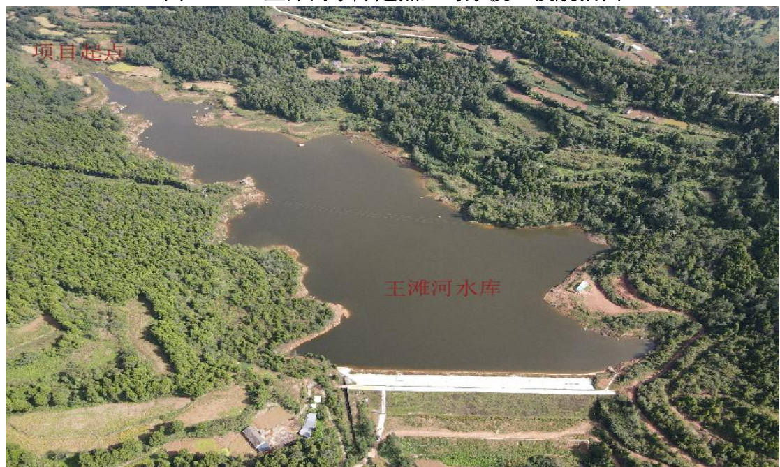
图 3.2-3 王滩河水库起点至马家渡口段航拍图
